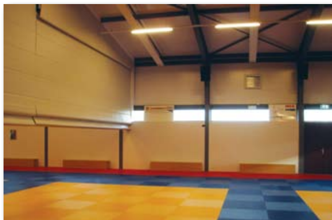
Sandwichdakpanelen toegepast boven een sportzaal.
