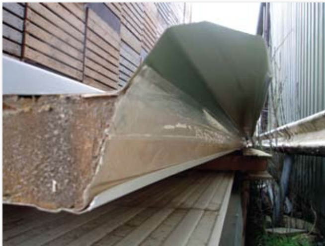
Sandwichdakpanelen geleverd zonder fabrieksmatig aangebrachte afdichtband in de langsvoeg.
