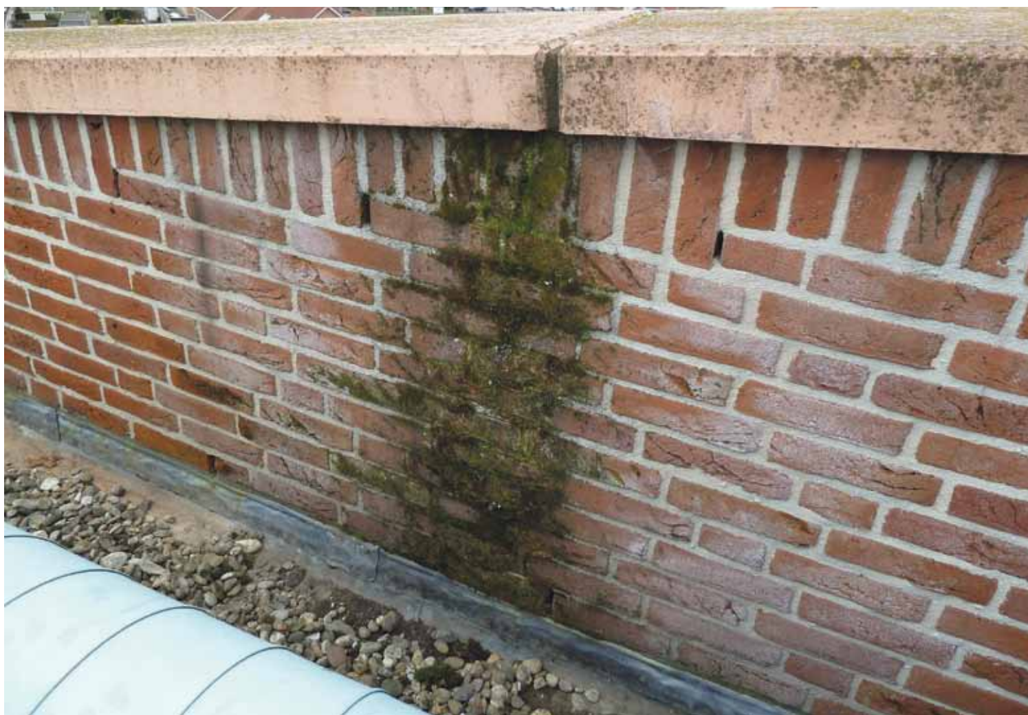
Vervuilde/vermaste gevel door gebrekkige detaillering.
