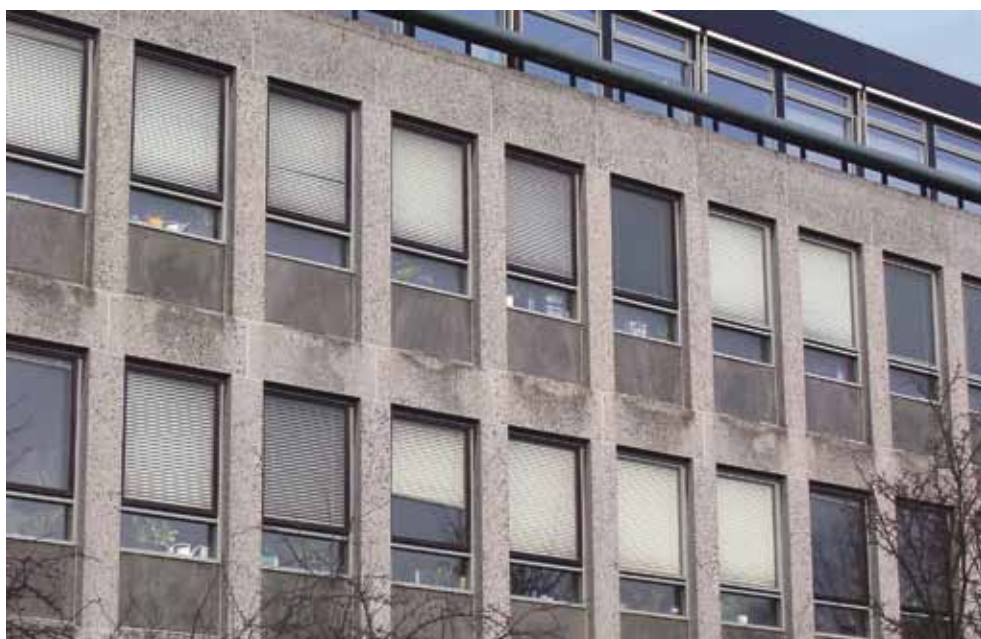
Vervuilde/vermaste gevel door gebrekkige detaillering.
