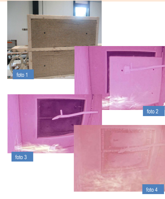
Waarneming tijdens test: Foto 1: Constructie, vakvullingen (vanaf de vuurzijde) Foto 2: Beproeving, (VZ) tijdens wegvallen beschermingsplaat na 45 minuten Foto 3: Beproeving, (VZ) direct na het wegvallen beschermingsplaat na 45 minuten Foto 4: Beproeving, (VZ) na 60 minuten
